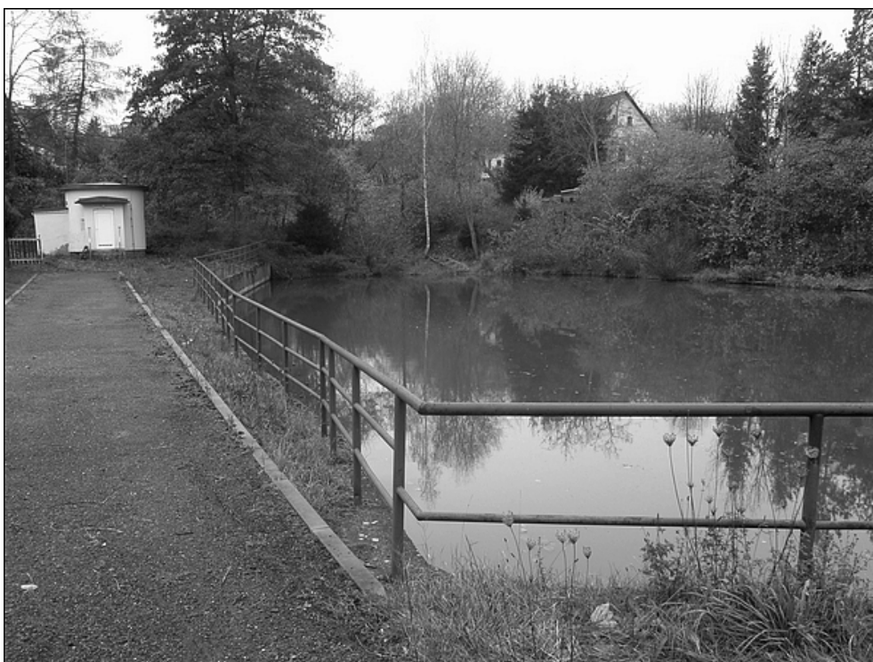
F15 - požární nádrž
